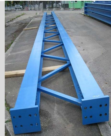
AUSGEFACHTER HEA-TRÄGER ALS TRAGKONSTRUKTION FÜR LEITUNGEN ÜBER GROßE SPANNWEITEN WIE Z.B. STRASSEN
